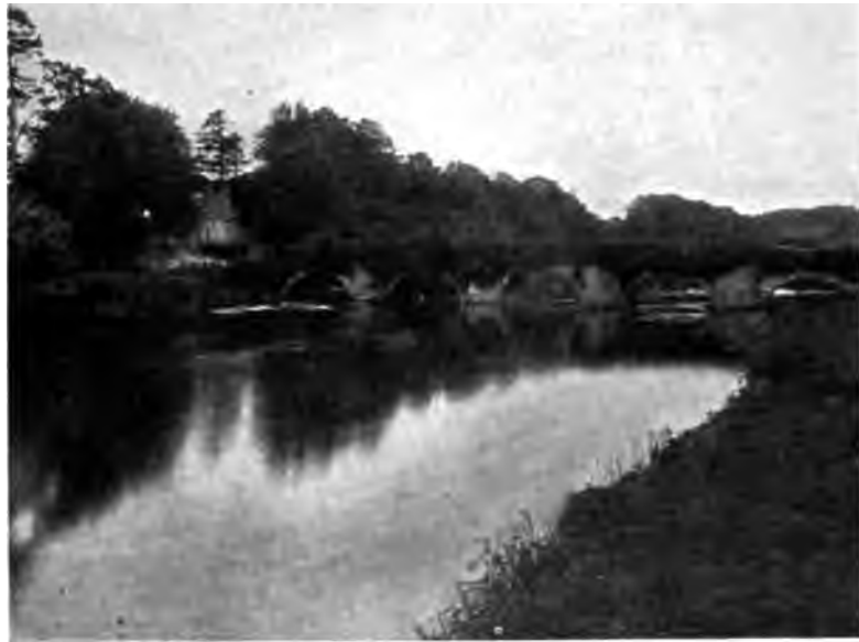
OLD BRIDGE AT LLECHRYD.
